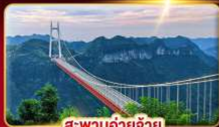
สะพานอ้ายจ้าย
